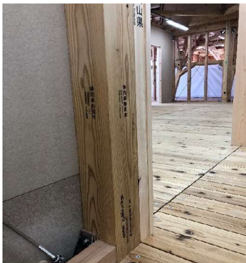
選手村ビレッジプラザ A 棟 柱
